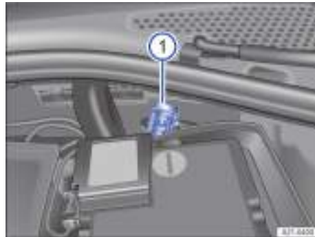
Fig. 173 En el vano motor: toma para la ayuda de arranque (terminal de masa).
